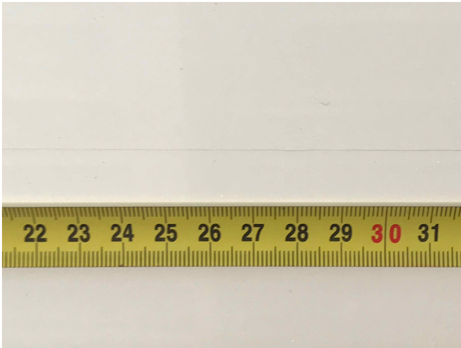
La même fissure bien nette
